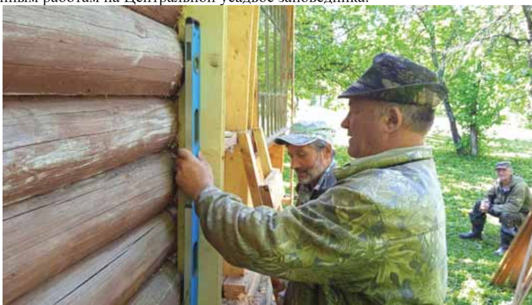
Ремонт бани. На фото Колосов И.Н., Дудков В.Г., Максимов А.В. Фото Тимаков В.М.
