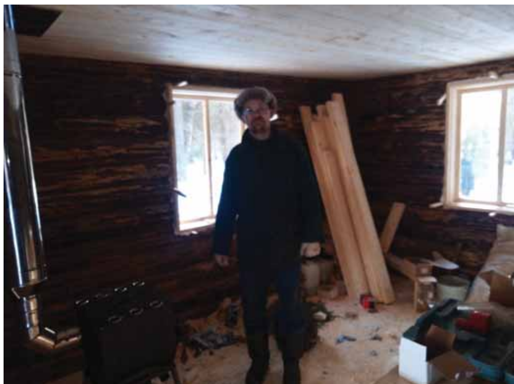
Строительство лесного кордона «Мартиновка». На фото Шубенко Д.В. Фото Севостьянов А.В.
